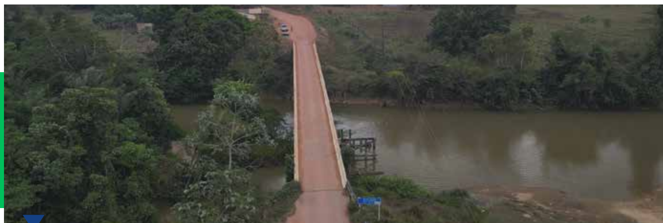
Ponte de concreto sobre o Rio Preto em Cujubim foi uma obra histórica. Agora produtores rurais têm condições de escoar sua produção!
